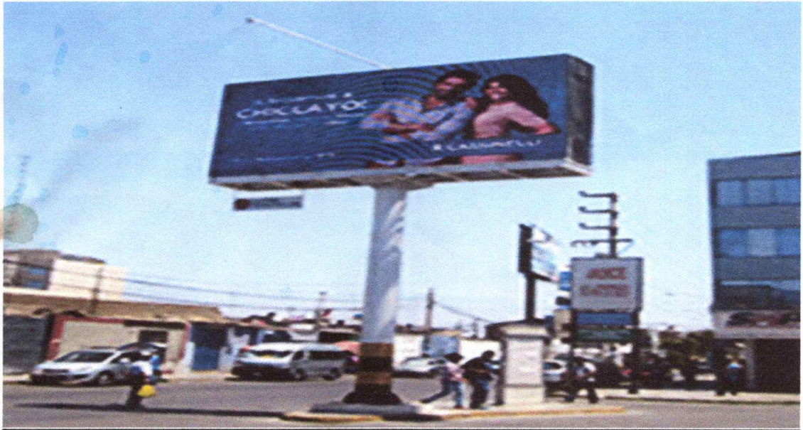
Imagen 3: El Panel Monumental Unipolar (el elemento de apoyo fijo se encuentra en la parte central).
