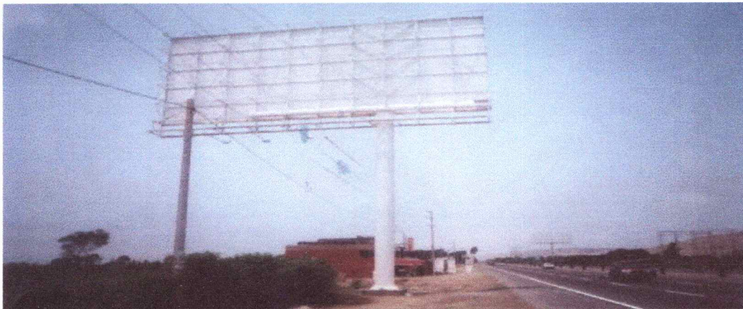
Imagen 2: El Panel Unipolar no cumple con la DMS – Distancia Mínima de Seguridad con respecto a la línea eléctrica.
