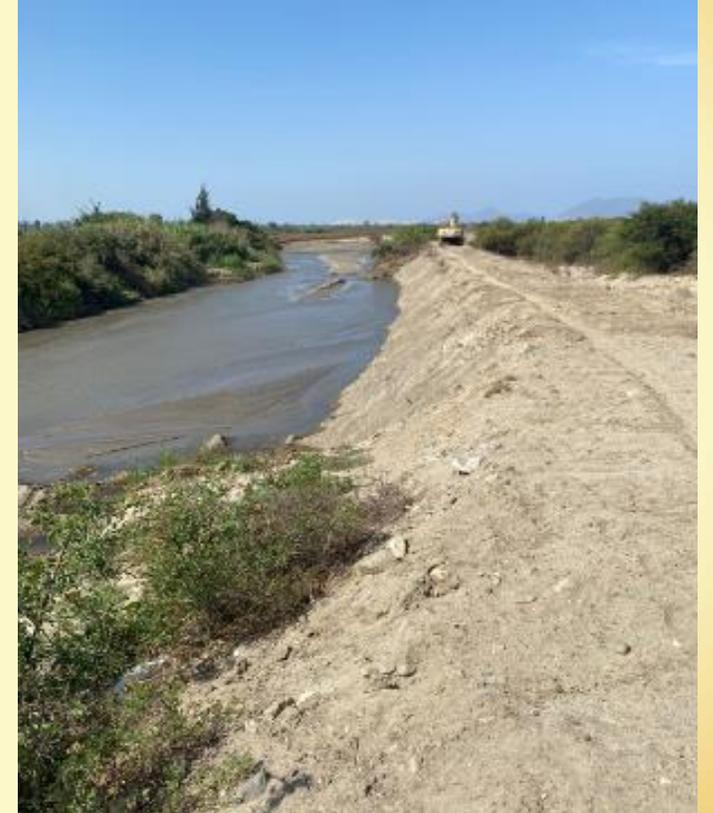
**TRABAJOS DE CONFORMACION DE DIQUE Y COLOCACION DE ROCA AL VOLTEO EN EL KM 6 - 7 DEL RIO LACRAMARCA A CONSECUENCIA DE LA LLUVIA DEL 13 DE MARZO**
